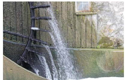
Unterschlächtiges Wasserrad (Quelle: Fam. Peschke)
